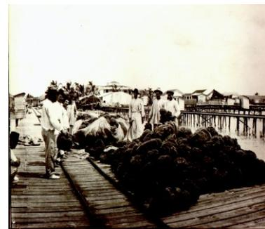
En abril de 1847 se instaló en su alrededor una farola que servía como señal para las embarcaciones que viajaban en el Golfo. Entre 1854-1855, atendiendo al tráfico marítimo de cabotaje y comercial en general, se alargó y ensanchó el muelle, se le dotó de doble carrilera y se construyeron dos almacenes. Gran parte del comercio de los pueblos y ciudades del sur de la isla de Cuba con la capital se realizó a través de este.
